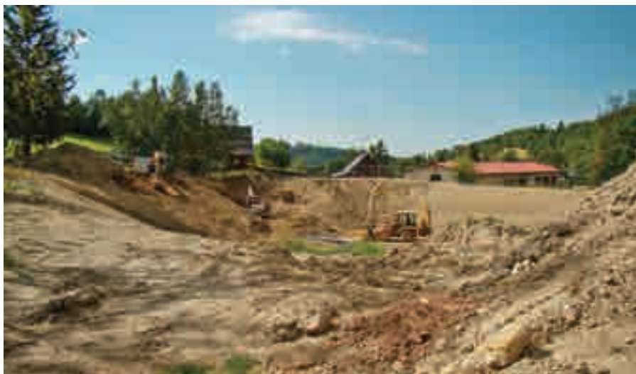
Hloubení nádrže na zasněžování v místě bývalého koupaliště
