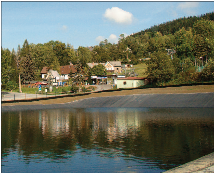
Nádrž na zasněžování vybudovaná v místě koupaliště, foto Z. Strnádková
